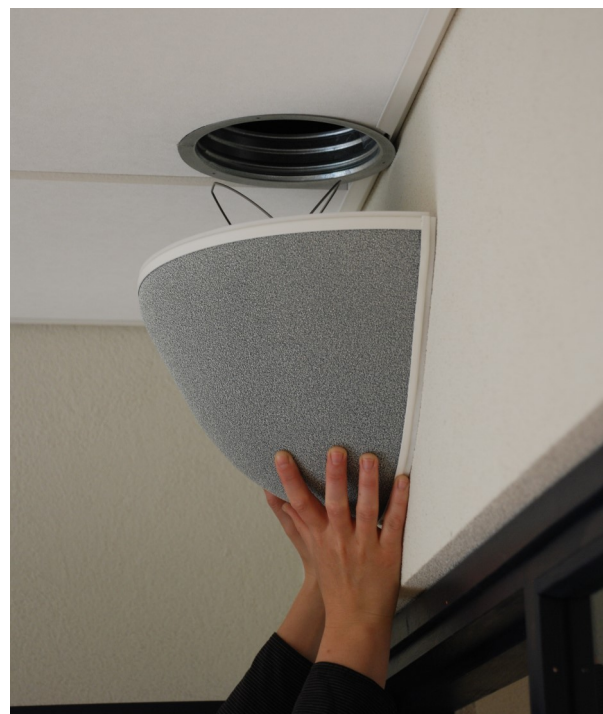
Bild 2: Lätt montering med fjäderfäste
